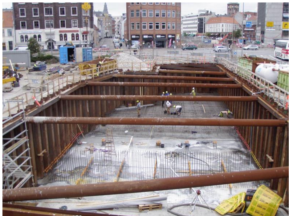
Figur 25: Pumpestation ved udløb af Aarhus Å i havnen, i anlægsfasen.
